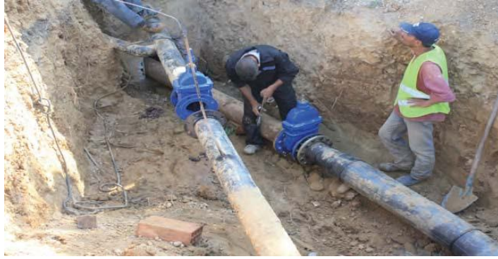
Branchement de canalisation A E P
